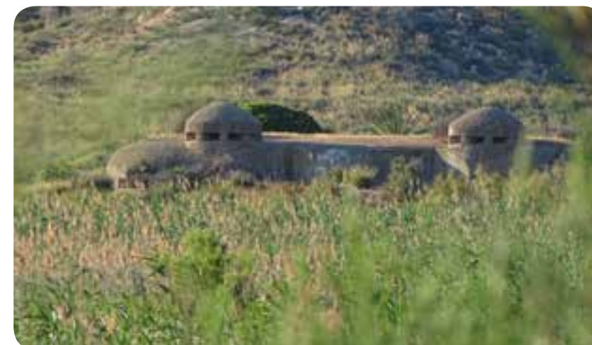
Seguimiento del estado del patrimonio histórico, civil y militar de "El Clot".
